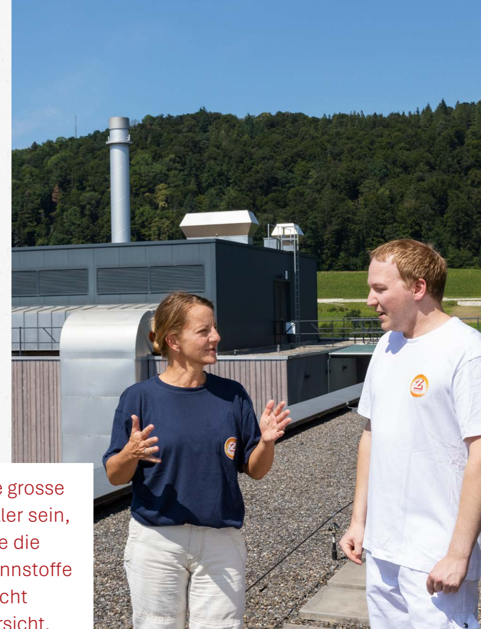
Silvia Goerke und Diego Pallaoro, Projektleiter Produktion, mit Weitblick über die Produktionsanlagen für Chips und Snacks am Standort Spreitenbach.
